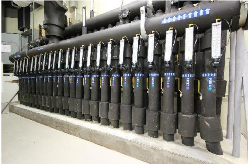
Géothermie – Réseau de conduits menant au puits géothermique – Source : Solutions Novika
